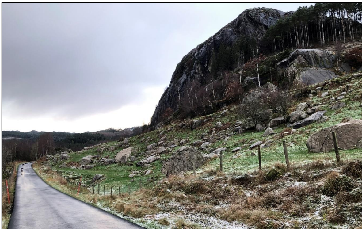
Figur 10 Skrent på nordsiden av Hetlandsvegen som ligger i et aktsomhetsområde for både steinsprang og snøskred.
